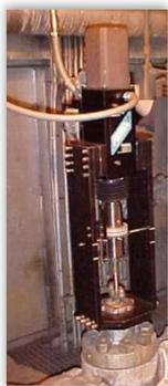
El reemplazo de los actuadores neumáticos con actuadores en el control del agua de alimentación puede generar beneficios inmediatos para cualquier planta de energía. Los ahorros en mantenimiento se pueden realizar de inmediato mediante una vida útil mejorada de los internos de la válvula de control, lo que reduce los costos de mano de obra y materiales.
